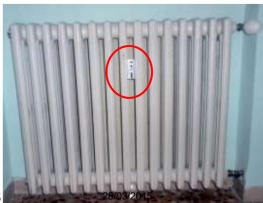
Il progetto dell'impianto di contabilizzazione deve contenere un elenco con la «potenza nominale» di ciascun corpo scaldante
